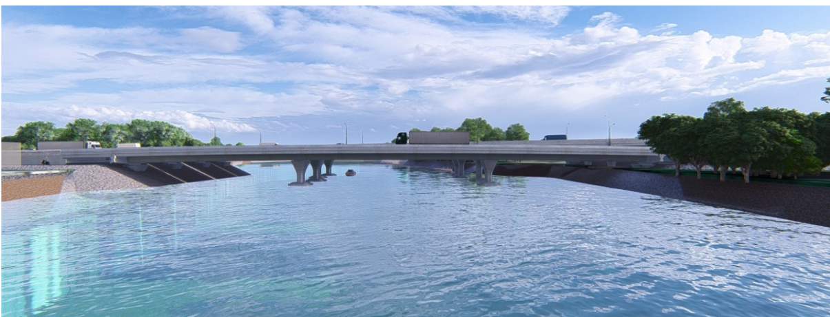
รูปที่ 7.2.1-1 รูปแบบที่ 1 สะพานยกระดับตามแนวทางหลวงหมายเลข 43 (Fly Over) ร่วมกับวงเวียน (Roundabout)
