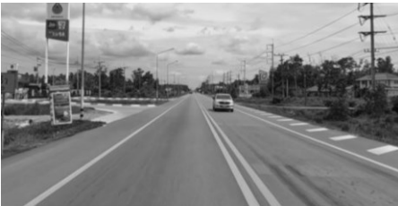
กม.7+000 บริเวณทางรถไฟ ตัด ทล.4085
