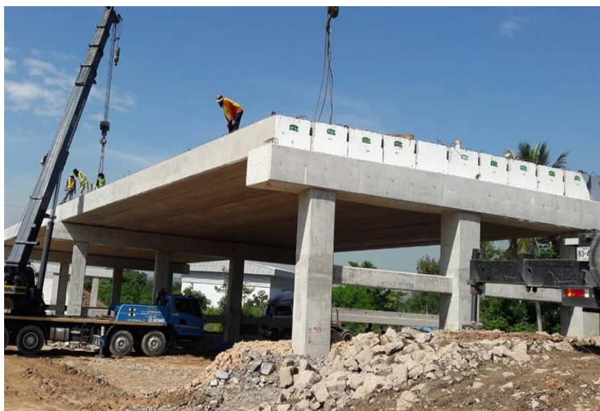
รูปที่ 7.3.3-1 สะพานคานรูปกล่องวางเรียงชิดติดกัน (Multi - Box Beam)
