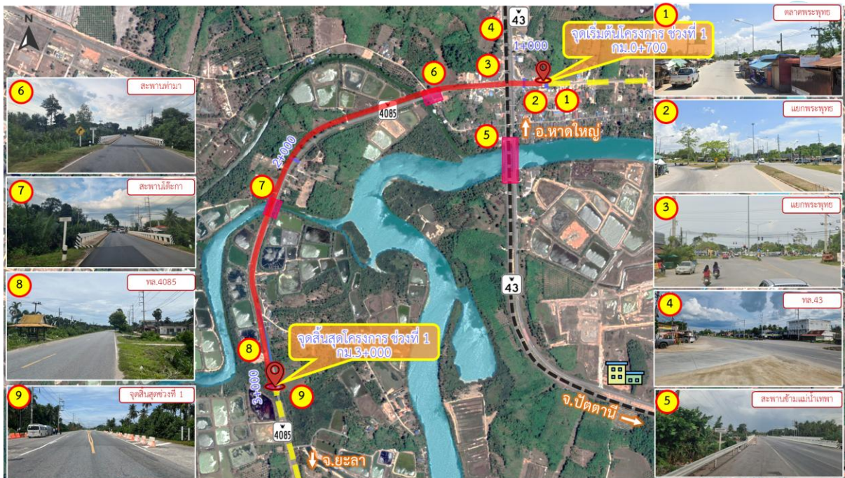
รูปที่ 4-2 สภาพทั่วไปบริเวณโครงการ ช่วงที่ 1
